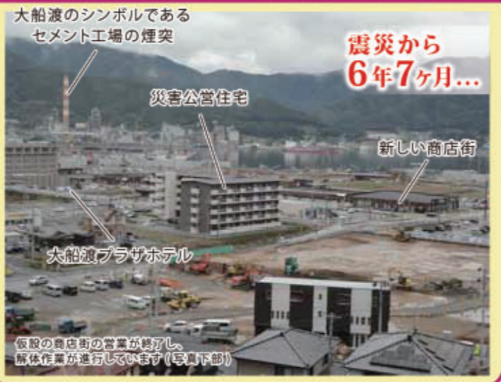
大船渡のシンボルであるセメント工場の煙突 災害公営住宅 新しい商店街 大船渡プラザホテル 仮設の商店街の営業が終了し、解体作業が進行しています(写真下部)
