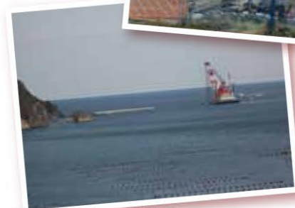
↑湾口防波堤工事の様子
