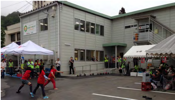
← 写真奥が、カリタス釜石の新しい建物
