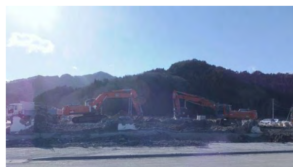
鶴住居地区防災センターの取り壊しの様子
