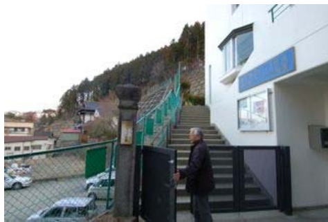
↑気仙沼教会直下の津波被害を見る司教
